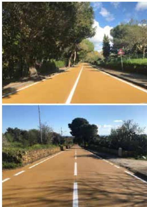
Una volta eseguito il taglio e la demolizione della pavimentazione stradale esistente, per una profondità di circa 10 cm. Viene poi realizzato uno strato di base in conglomerato con bitume distillato 50-70 o 70-100 e aggregato pezzatura 0/32, steso con vibrofinitrice, e compattato con rullo vibrante, a ottenere uno spessore di spessore 6-7 cm
