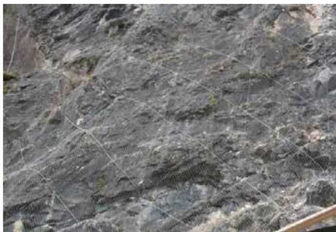
FIGURA 30. Imbrigliamento diretto del versante roccioso instabile mediante impiego di reti e funi d'acciaio zincato fissati alla roccia con una maglia di chiodature.
