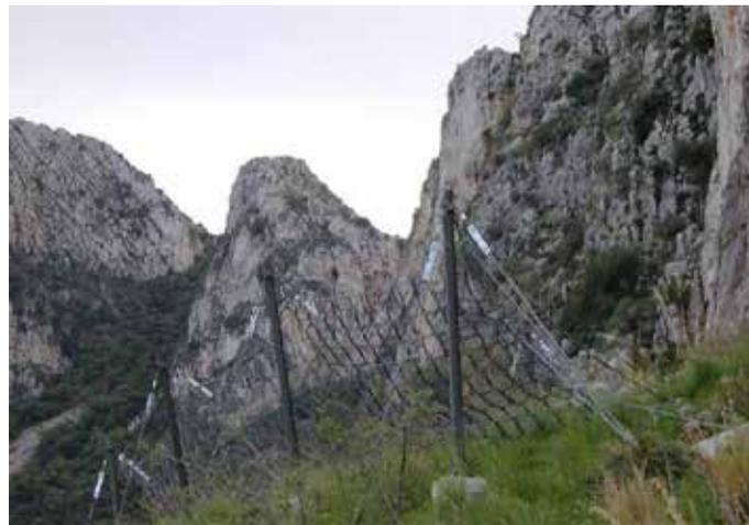
FIGURA 29. Seconda tipologia di barriere elastiche paramassi
