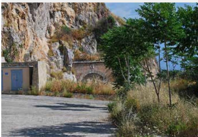
FIGURA 9. Galleria Rocca - alternanza di tratte rivestite con tratte prive di rivestimento lato Monreale
