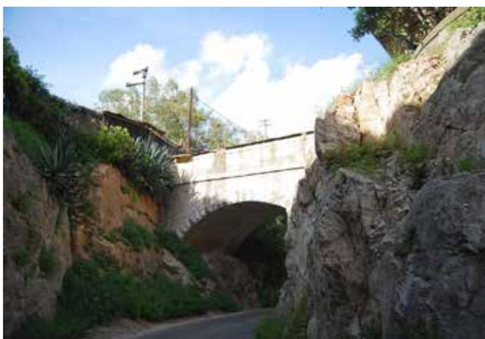
FIGURA 16. Evidenza della buona qualità della roccia su cui sono impostate le fondazioni di spalla del ponte ad arco Luparello
