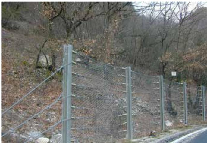
FIGURA 28. Prima tipologia di barriera elastica paramassi
